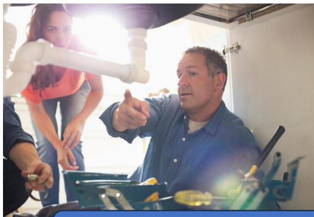
Mentenanță regulată previne risipa costisitoare de apă.
